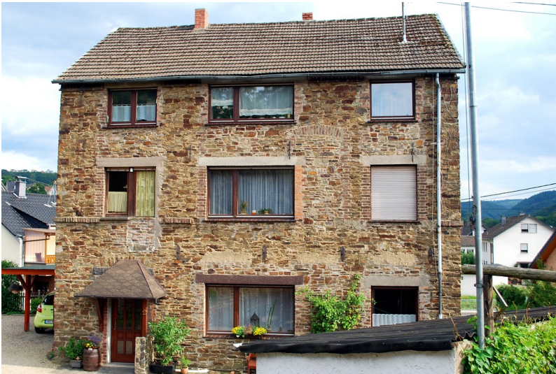
Alte Schule in Niederbreitbach (2014) Fotograf/Urheber: Frings, Alina
