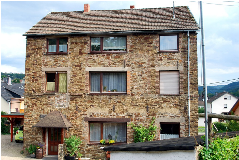
Alte Schule in Niederbreitbach (2014) Fotograf/Urheber: Frings, Alina
