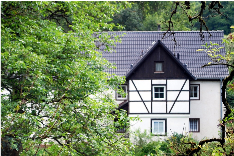
Teilsicht der Clemenshütte in Niederbreitbach (2014) Fotograf/Urheber: Frings, Alina
