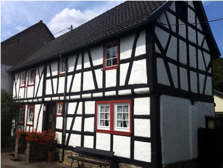
Wohnhaus des Herrenhofes in der Herrenhofstraße in Niederbreitbach von der Hofseite (2014) Fotograf/Urheber: Frings, Alina
