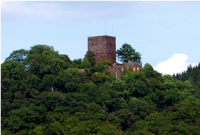
Teilansicht der Burgruine Neuerburg bei Niederbreitbach (2014) Fotograf/Urheber: Frings, Alina
