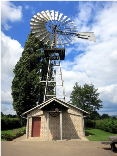
Das Windrad südwestlich des Weidtmannschen Schlösschens in Koblenz-Metternich (2014). Fotograf/Urheber: Florian Johann
