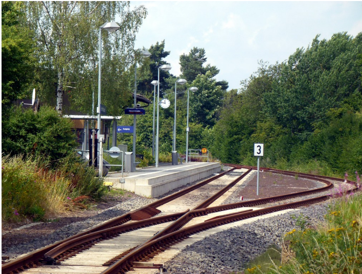
Bahnsteig und Gleisanlagen des Bahnhofs Emmelshausen (2014) Fotograf/Urheber: Gras, Christopher
