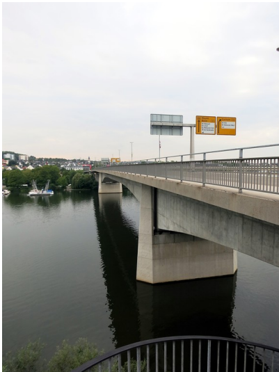
Die Kurt-Schumacher-Brücke über die Mosel in Koblenz-Metternich, Blick in Richtung Nordwesten (2014). Fotograf/Urheber: Florian Johann
