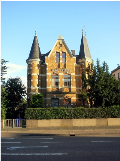
Blick auf die "Villa Borussia" an der Trierer Straße in Koblenz-Metternich (2014). Fotograf/Urheber: Florian Johann
