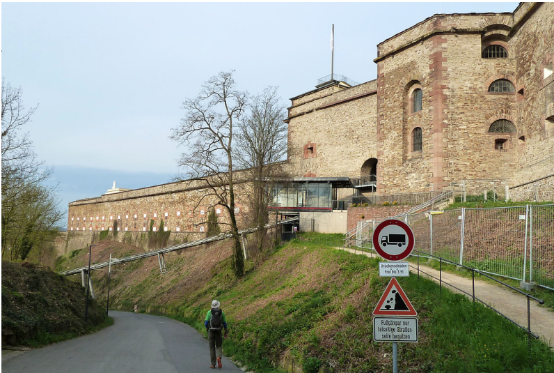
Festung Ehrenbreitstein, Festungskirche, grosse Traverse und Niedere Ostfront mit Schrägaufzug (2017) Fotograf/Urheber: Katrin Becker
