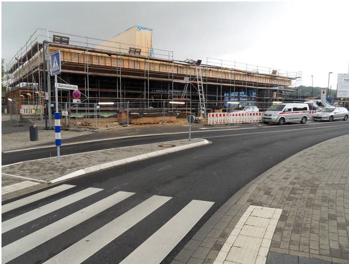
Das im Bau befindliche neue Bahnhofsgebäude in Horrem (2013) Fotograf/Urheber: Sandra Lüling
