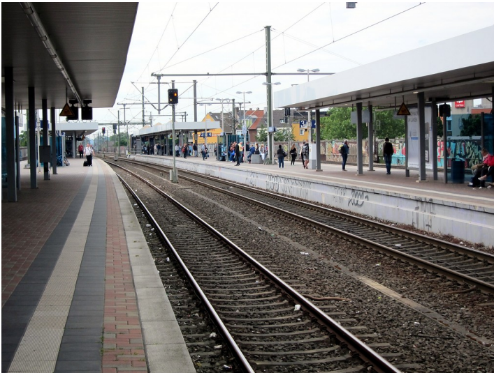
Bahnsteige und Gleiskörper des Bahnhofs Köln-Ehrenfeld (2015) Fotograf/Urheber: Knieps, Elmar
