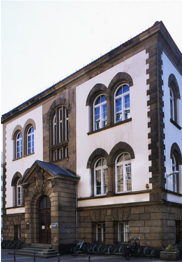
Die Alte Bibliothek der RWTH Aachen, Wüllnerstraße 3, in Aachen (2011). Fotograf/Urheber: Jürgen Gregori
