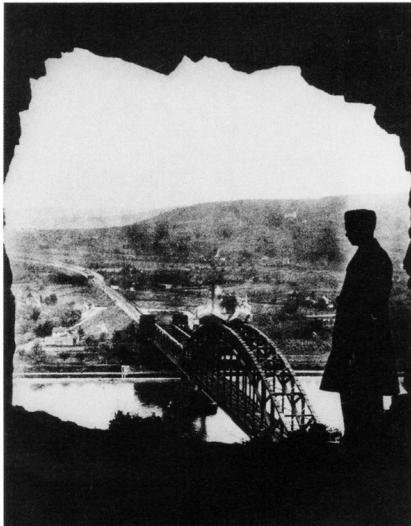
Die Brücke von Remagen kurz vor der Einnahme durch die US-Armee am 7. März 1945 (historische Aufnahme, Landeshauptarchiv Koblenz, Bestand 710, Nr. 7788). Fotograf/Urheber: unbekannt
