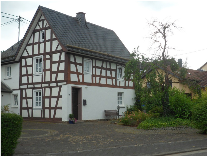
Das Fachwerkhaus "Boden" in der Ortsgemeinde Roßbach (2014). Fotograf/Urheber: Alexander Lo Iacono
