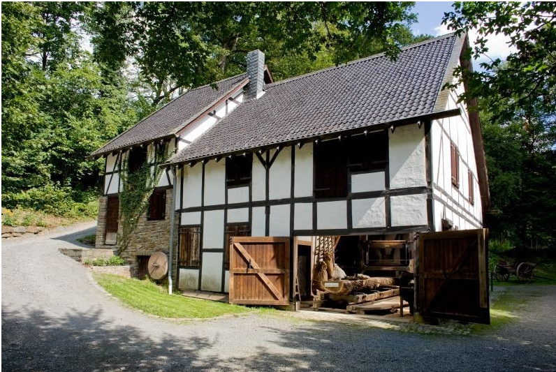
Das in den Hang gebaute Fachwerkgebäude der Gaderother Mühle mit offenem Holztor (2011). Fotograf/Urheber: Arendt, Stefan
