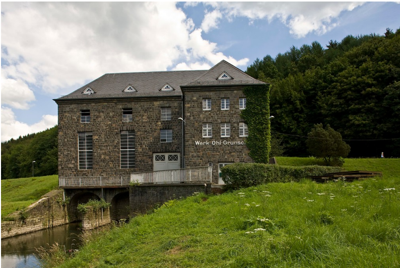
Wasserkraftwerk Ohl-Grünscheid Fotograf/Urheber: Nicole Schäfer
