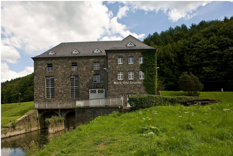
Wasserkraftwerk Ohl-Grünscheid Fotograf/Urheber: Nicole Schäfer
