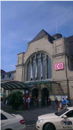
Teilsicht des Empfangsgebäudes des Koblenzer Hauptbahnhofs (2014) Fotograf/Urheber: Breuer, Katharina
