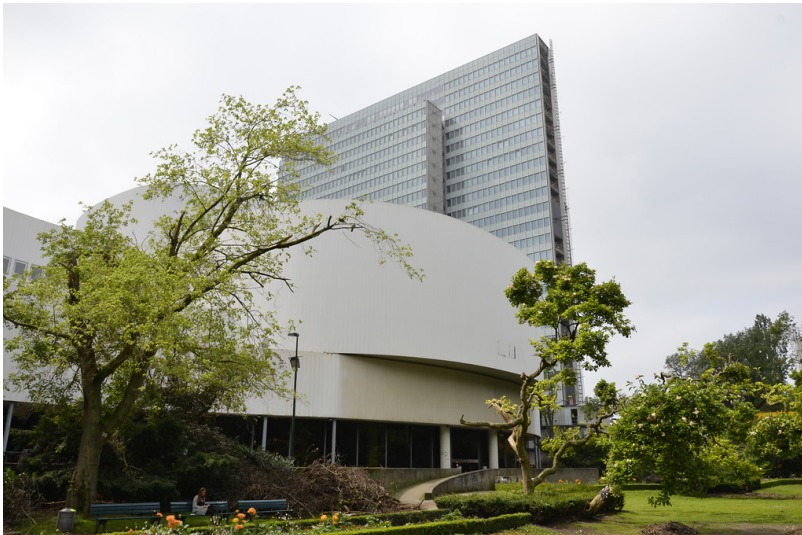
Das Schauspielhaus vor dem Dreischeidenhaus in Düsseldorf. Auch die Sturmschäden (Unwetter vom 9. Juni 2014), die den Hofgarten stark getroffen haben, sind deutlich zu erkennen (Aufnahme vom Juli 2014). Fotograf/Urheber: Leblebici, Suzan
