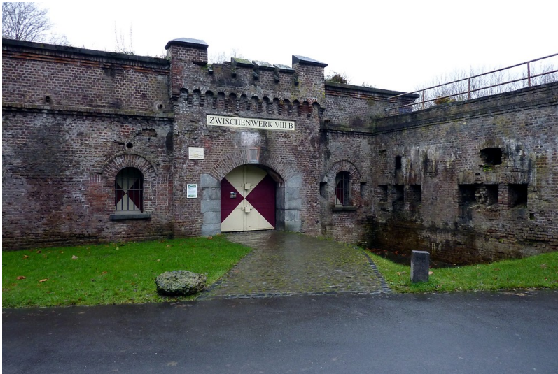
Eingang zum Zwischenwerk VIIIb des äußeren preußischen Festungsgürtels in Köln (2014) Fotograf/Urheber: Suzan Leblebici
