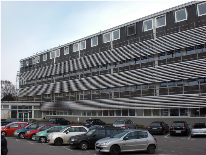
RWTH Sammelbau (ehemalige Pädagogische Hochschule), Ahornstraße 55 in Aachen, Hauptgebäude (2011). Fotograf/Urheber: Wild, Moritz
