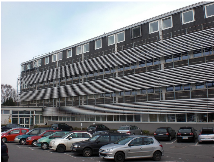
RWTH Sammelbau (ehemalige Pädagogische Hochschule), Ahornstraße 55 in Aachen, Hauptgebäude (2011). Fotograf/Urheber: Wild, Moritz
