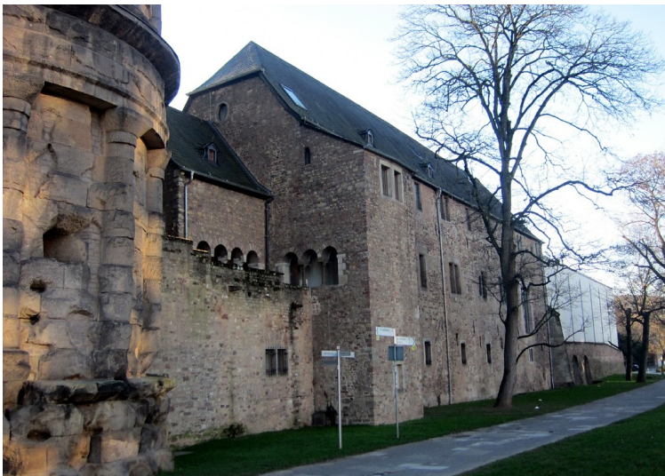
Simeonsstift (Kanonikerstift St. Simeon) in Trier, Ansicht des Nordflügels von der Nordallee aus (2014). Fotograf/Urheber: Franz-Josef Knöchel
