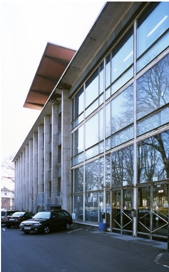
RWTH Institut für Elektrische Nachrichtentechnik und Hochfrequenztechnik, Haupteingang Fotograf/Urheber: Gregori, Jürgen
