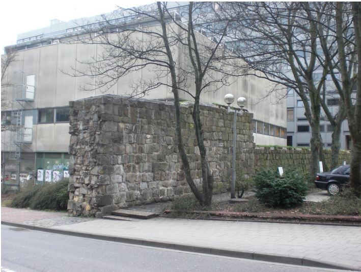
Teilstück der Barbarossamauer in Aachen Fotograf/Urheber: Wild, Moritz
