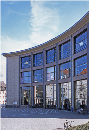
Das große Hörsaalgebäude der RWTH Aachen in der Wüllnerstraße 9 Fotograf/Urheber: Gregori, Jürgen
