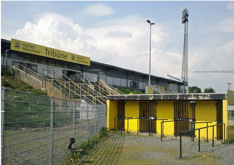
Stadion Alter Tivoli Aachen während der Abriss- und Rückbauarbeiten im April 2011 Fotograf/Urheber: Leblebici, Suzan
