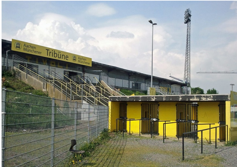
Stadion Alter Tivoli Aachen während der Abriss- und Rückbauarbeiten im April 2022 Fotograf/Urheber: Leblebici, Suzan
