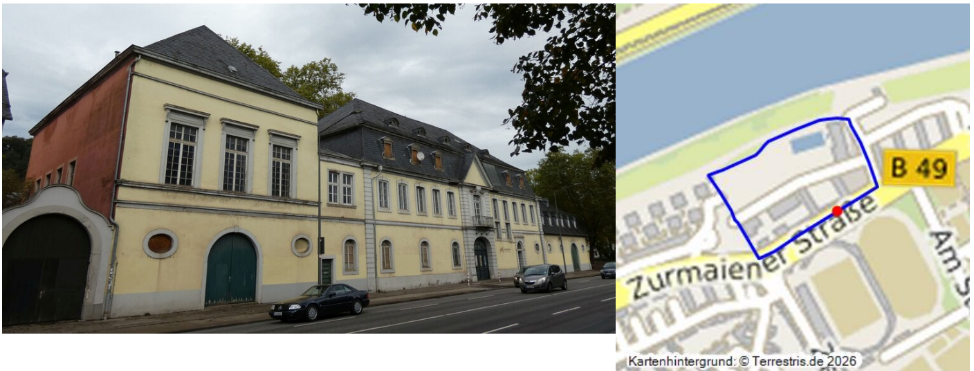
Jugend- und Kulturzentrum Exzellenzhaus in Trier (2023) Fotograf/Urheber: Matthias Röcke
