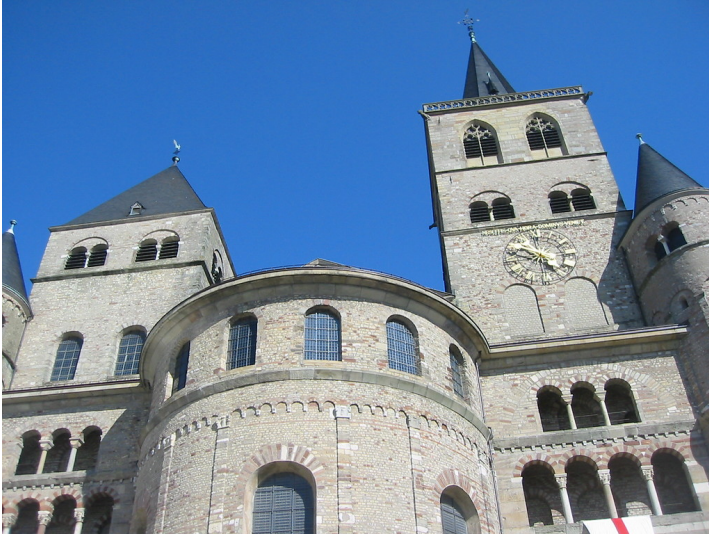
Oberer Teil der Westfassade des Trierer Domes, der aus der vormaligen Konstantinischen Doppelkathedrale hervorgegangen ist (2010) Fotograf/Urheber: Franz-Josef Knöchel
