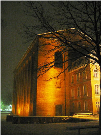
Die Römische Palastaula in Trier, die so genannte Konstantinbasilika, aus südlicher Richtung vom Palastgarten aus gesehen (2004). Rechts im Bild schließt sich ein Gebäudeteil des kurfürstlichen Palais an. Fotograf/Urheber: Franz-Josef Knöchel
