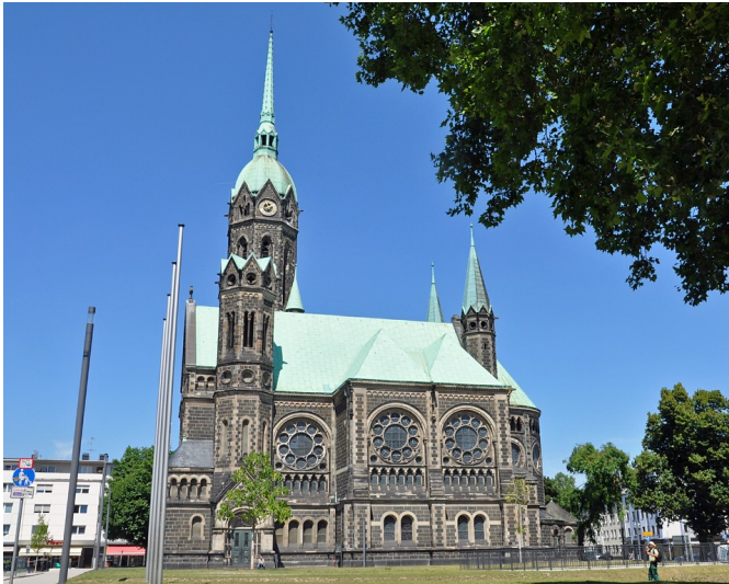
Südliche Ansicht der evangelischen Hauptkirche Rheydt im Denkmalbereich der Innenstadt in Mönchengladbach-Rheydt (2017). Fotograf/Urheber: Franziska, Ostfeld
