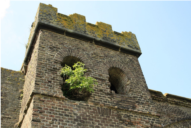
Bewachsenes Mauertürmchen der Eisenbahnbrücke Wesel (2014) Fotograf/Urheber: Biologische Station im Kreis Wesel
