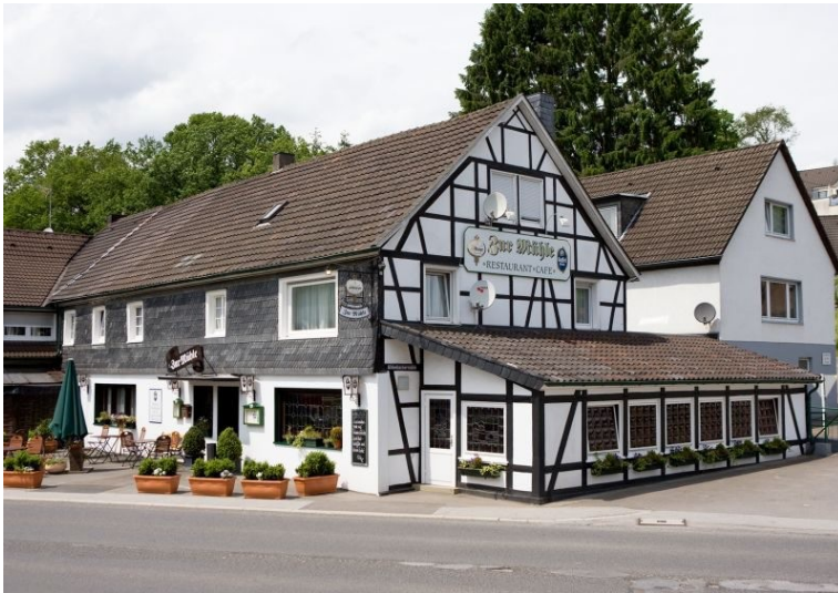
Ahlenbacher Mühle Fotograf/Urheber: Arendt, Stefan
