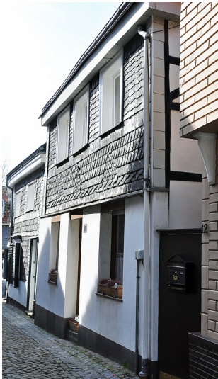
Wohnhaus Kaiserstraße 10 in Essen Kettwig Fotograf/Urheber: Buchholz, Karl-Heinz
