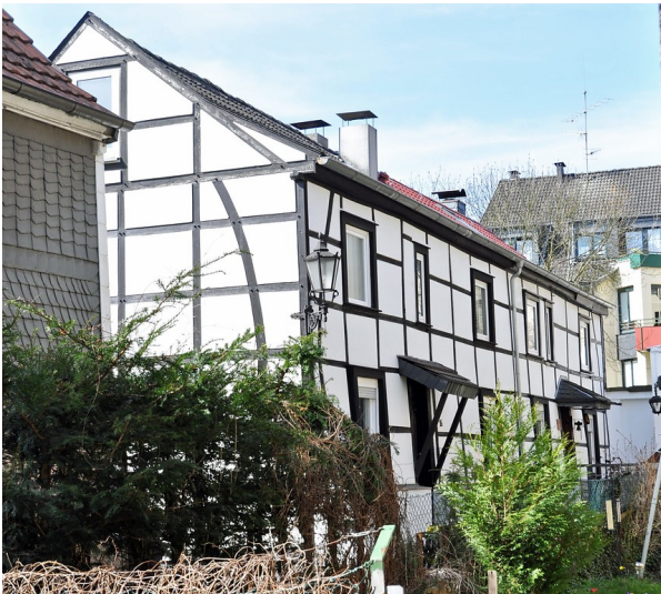
Wohnhäuser Kaiserstraße 16 und 18 in Essen Kettwig Fotograf/Urheber: Buchholz, Karl-Heinz
