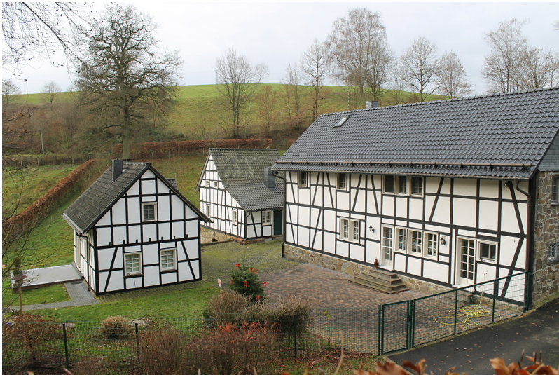
Gebäudekomplex der Birkenmühle in Neunkirchen-Seelscheid-Birken, in der Mitte hinten das Mühlengebäude (2013) Fotograf/Urheber: Schüler, Volker
