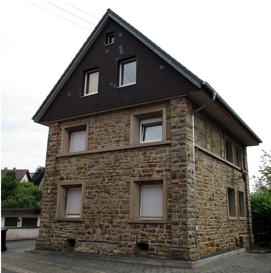
Das heute als Wohnhaus genutzte frühere Synagogengebäude in Ruppichteroth (2021). Fotograf/Urheber: Franz-Josef Knöchel
