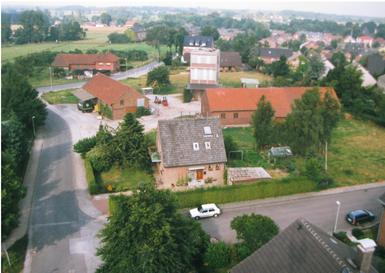
Aufnahme von einem Kran herunter auf die Gahlener Genossenschaft (1999). Man sieht einzelne Werksgebäude und Maschinen, aber auch die umliegenden Wohnhäuser. Fotograf/Urheber: Scheffler, Helmut
