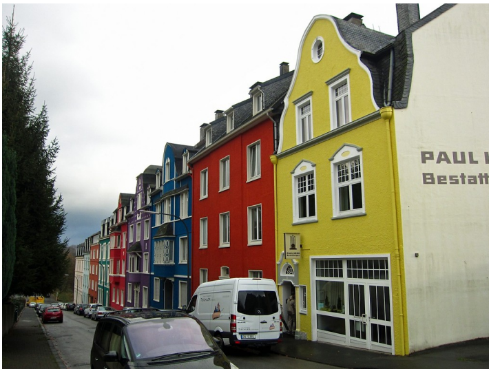
Die früher genossenschaftlichen Wohnhäuser in der Elsternstraße in Barmen, Ansicht aus westlicher Richtung (2014). Fotograf/Urheber: Franz-Josef Knöchel
