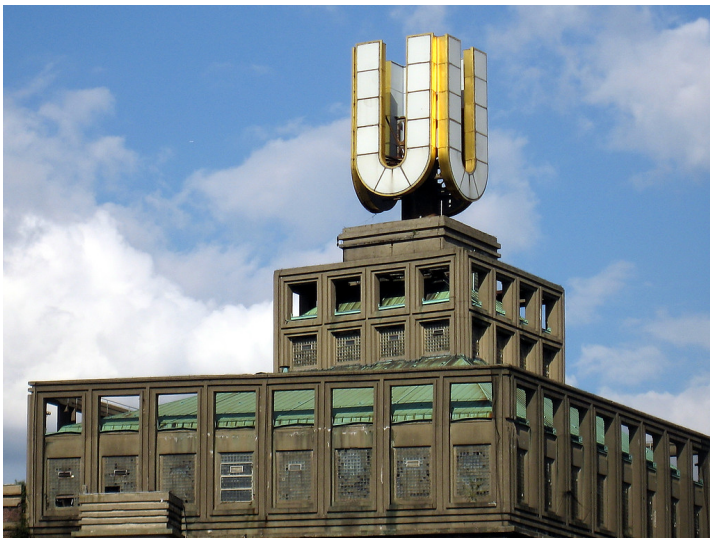
Oberer Teil der Westfassade des Hochhauses I der Union Brauerei in Dortmund (Brau und Brunnen AG), gekrönt von dem "Dortmunder U" (2007).
