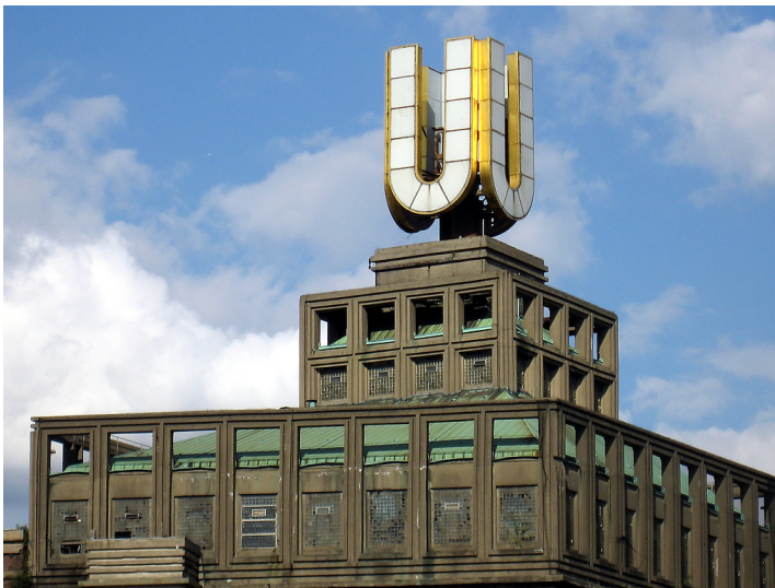
Oberer Teil der Westfassade des Hochhauses I der Union Brauerei in Dortmund (Brau und Brunnen AG), gekrönt von dem "Dortmunder U" (2007).
