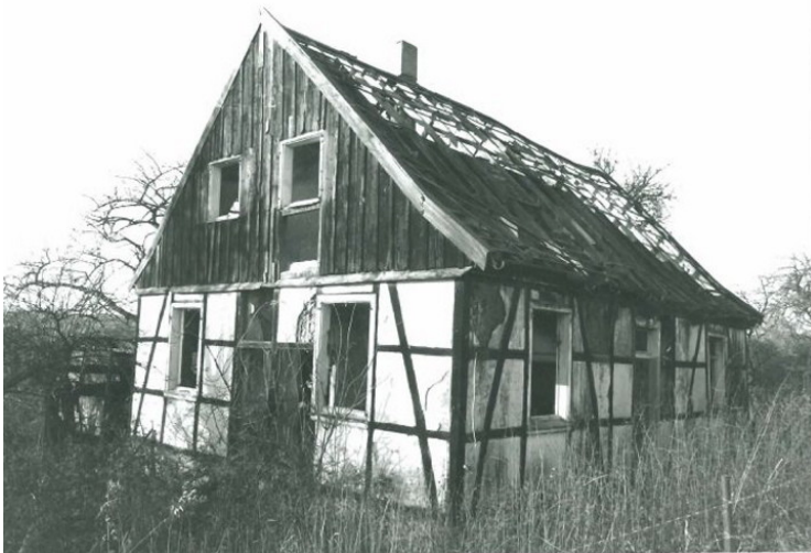
Schäferkotten Rennecke in Essen-Schuir (1985). Fotograf/Urheber: UDB Essen
