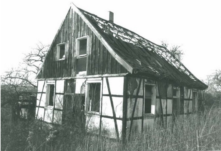
Schäferkotten Rennecke in Essen-Schuir (1985). Fotograf/Urheber: UDB Essen
