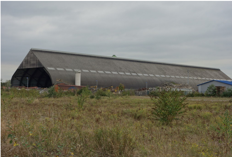
Rohkohlenmischhalle Pattberg (2016) Fotograf/Urheber: Kai-William Boldt
