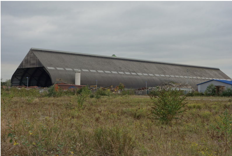
Rohkohlenmischhalle Pattberg (2016) Fotograf/Urheber: Kai-William Boldt
