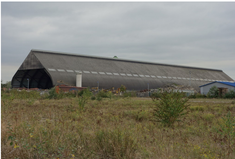
Rohkohlenmischhalle Pattberg (2016) Fotograf/Urheber: Kai-William Boldt
