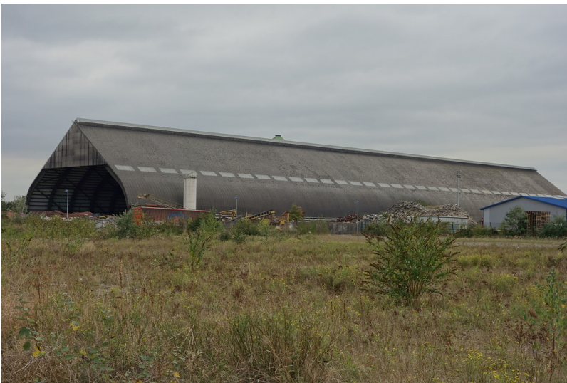
Rohkohlenmischhalle Pattberg (2016) Fotograf/Urheber: Kai-William Boldt
