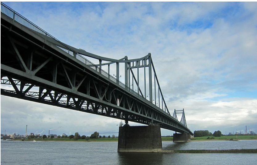
Die Rheinbrücke Uerdingen-Mündelheim von der westlichen Rheinseite aus gesehen (2014). Fotograf/Urheber: Franz-Josef Knöchel
