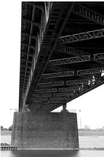
Blick auf die Unterseite der Rheinbrücke Uerdingen-Mündelheim zwischen Krefeld und Duisburg (2021). Fotograf/Urheber: Edgar Droste-Orlowski
