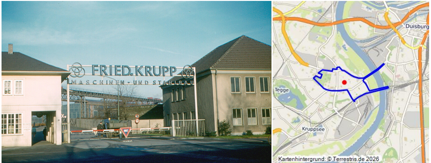
Die Einfahrt zum Krupp-Werk "Fried. Krupp Maschinen- und Stahlbau" an der Hochstraße in Duisburg-Rheinhausen (um 1960/61). Fotograf/Urheber: Roger W / roger 4336
