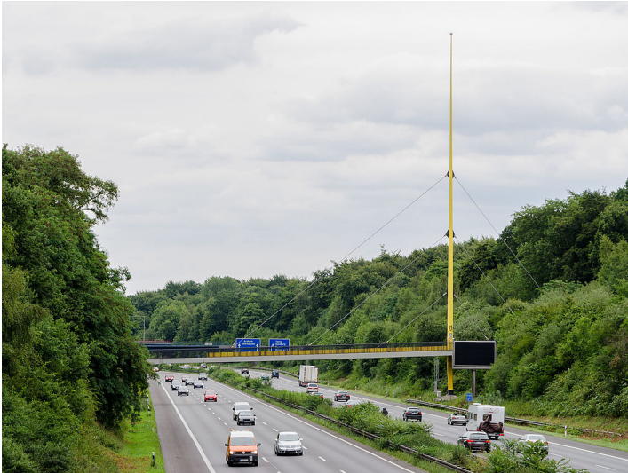
Die Expo-Brücke an der Bundesautobahn A3 entlang des Duisburger Stadtwaldes (2015).
